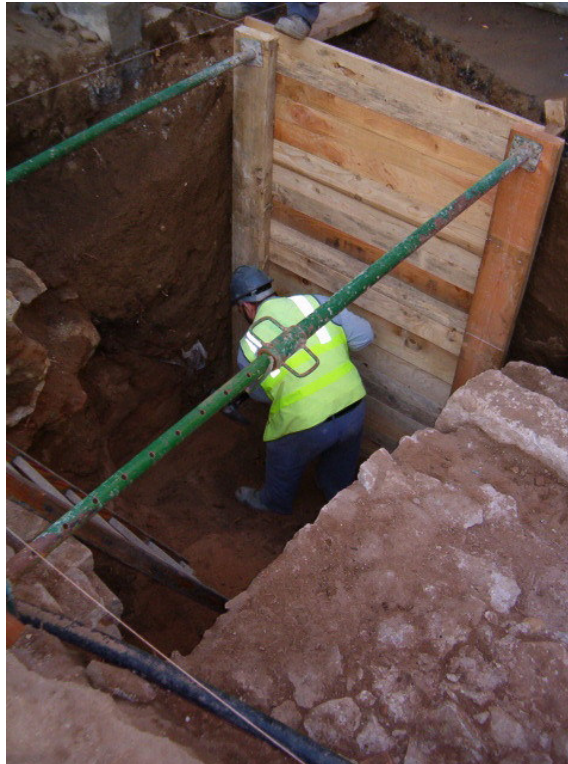
Detall de l'apuntament d'un dels talls de la fossa
